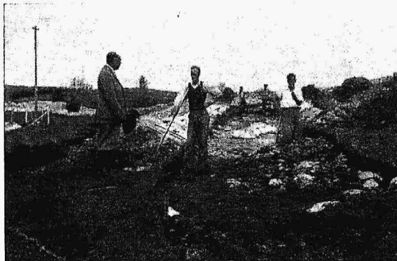
Nasi budują drogę w okolicy Neuchâtel
